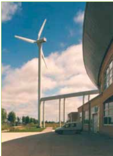
Eolienne à axe horizontale - Lycée Léonard de Vinci à Calais – Source : ARENE Ile-de-France
