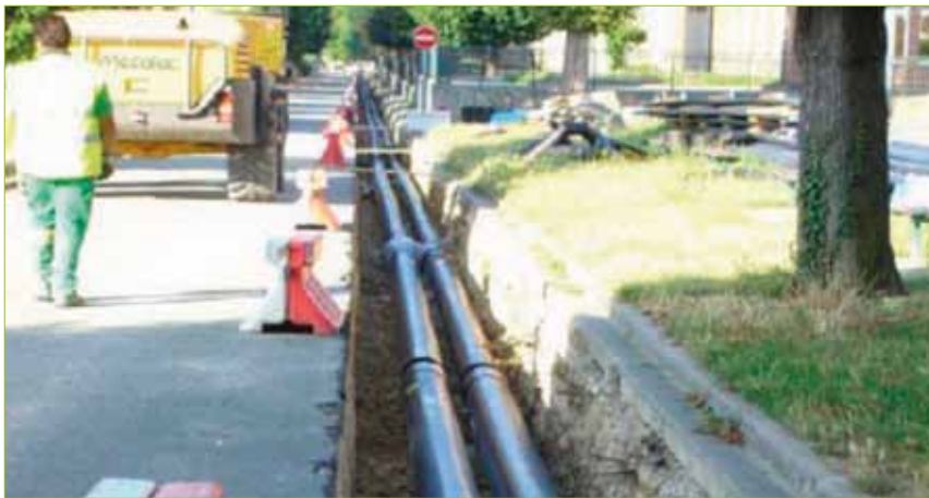
Tranchée d'un réseau de chaleur- Athis-Mons (91) Source : ARENE Ile de France – Philippe Salvi
