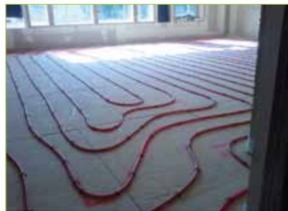
Thermostat d'ambiance – Source : photographie ADEME Chauffage au sol Source : photographie Ville d'Arcueil (Ecole Olympe de Gouges
