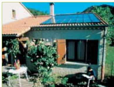
Chauffe-eau solaire collectif – Source : Paris Habitat Chauffage solaire – Source : Ademe
