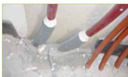
1) Adhésif d'étanchéité 2) Etanchéité sur un fourreau
