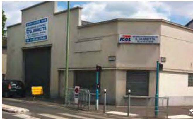
Les locaux de l'ancien garage lanetta, avenue de la Convention.
