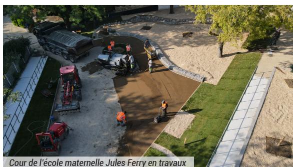
Cour de l'école maternelle Jules Ferry en travaux
